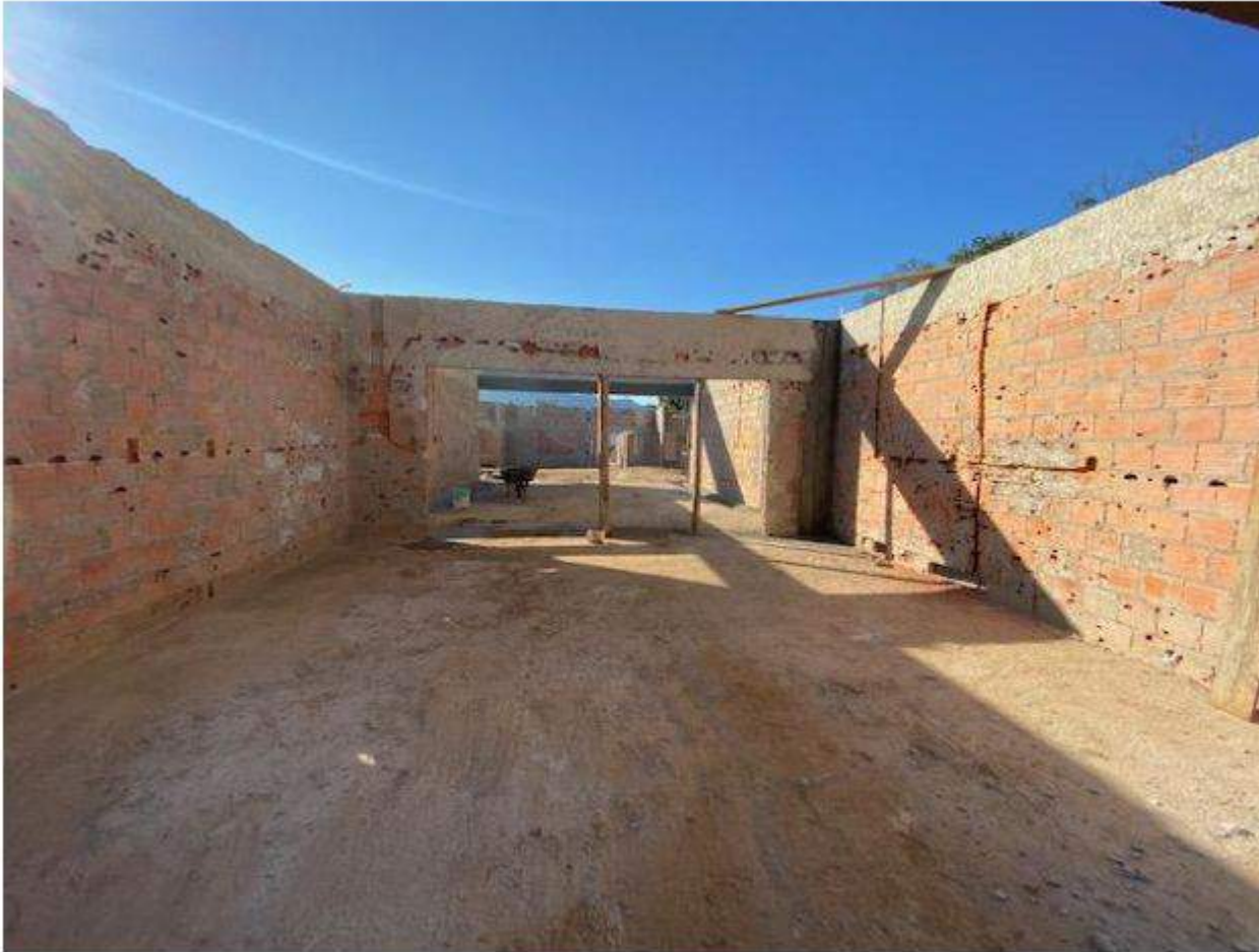
Corte para instalação tubulação elétrica
