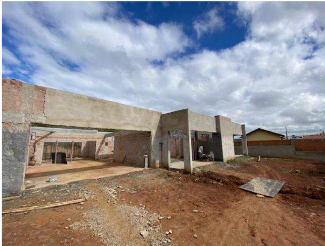
Reboco externamente das platibandas
