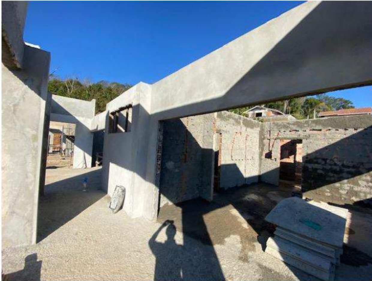
Reboco nas paredes externas
