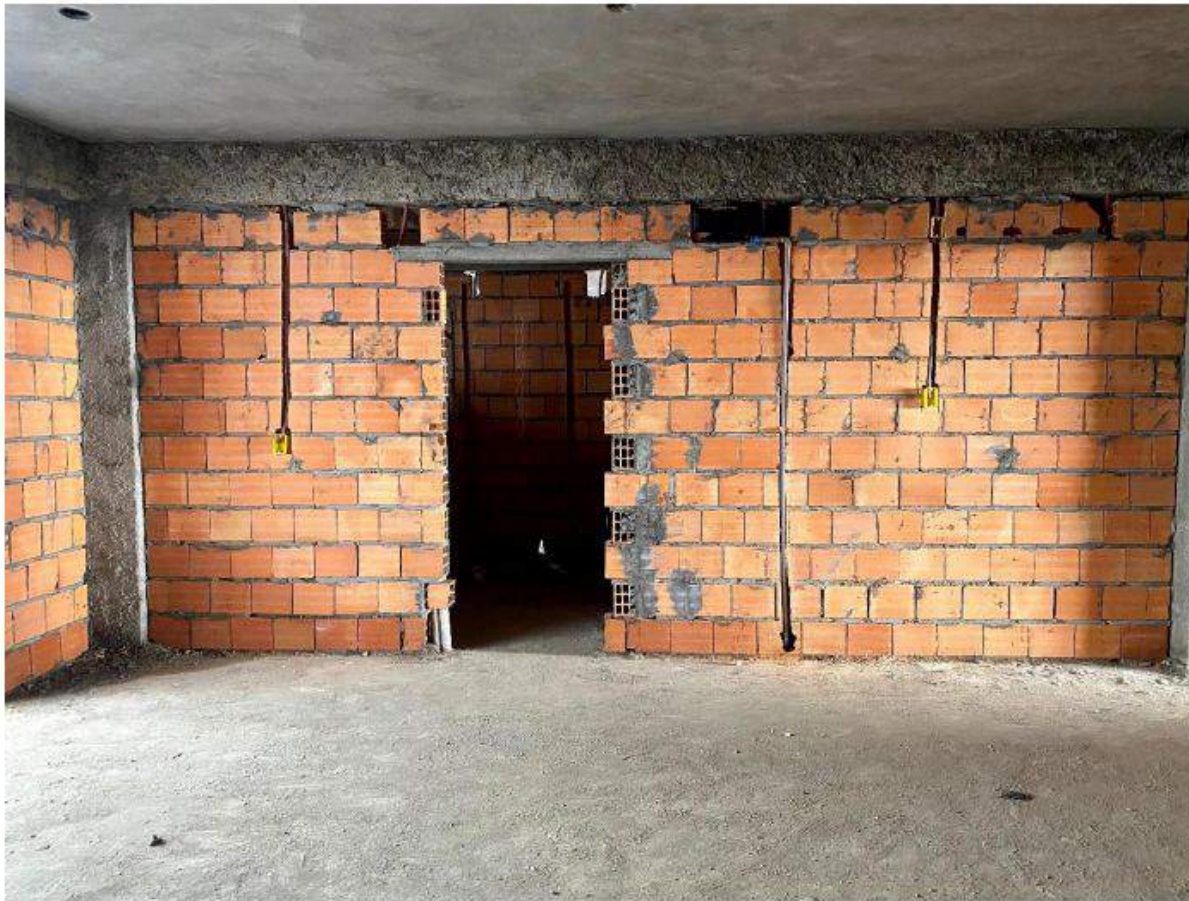
Sala de aula - tetos rebocados/alvenaria executadas/caixa espera de ar condicionado e drenagem/eletrodutos.
