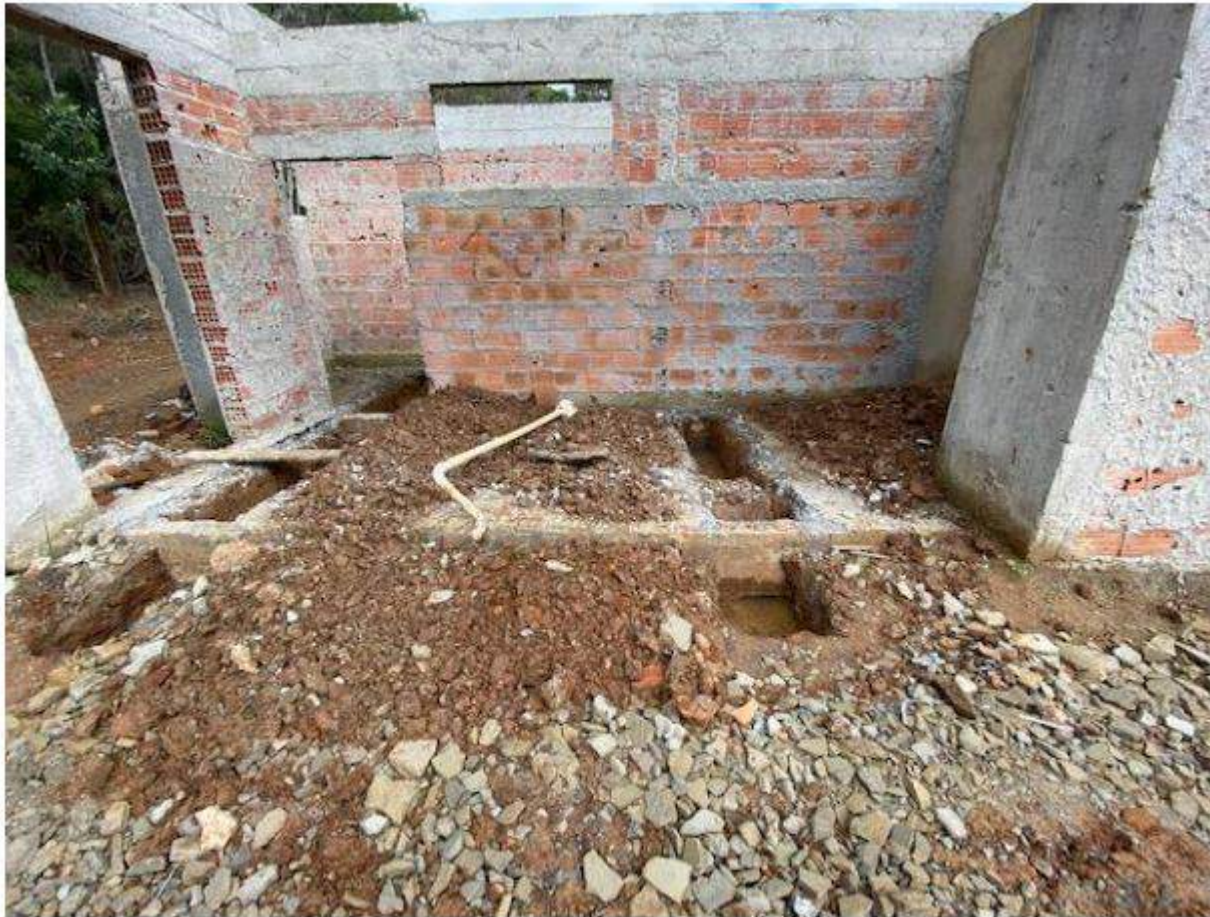
Remoção de infraestrutura de esgoto
