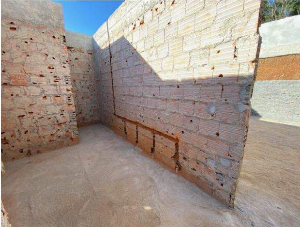
Corte para instalação tubulação hidrossanitária
