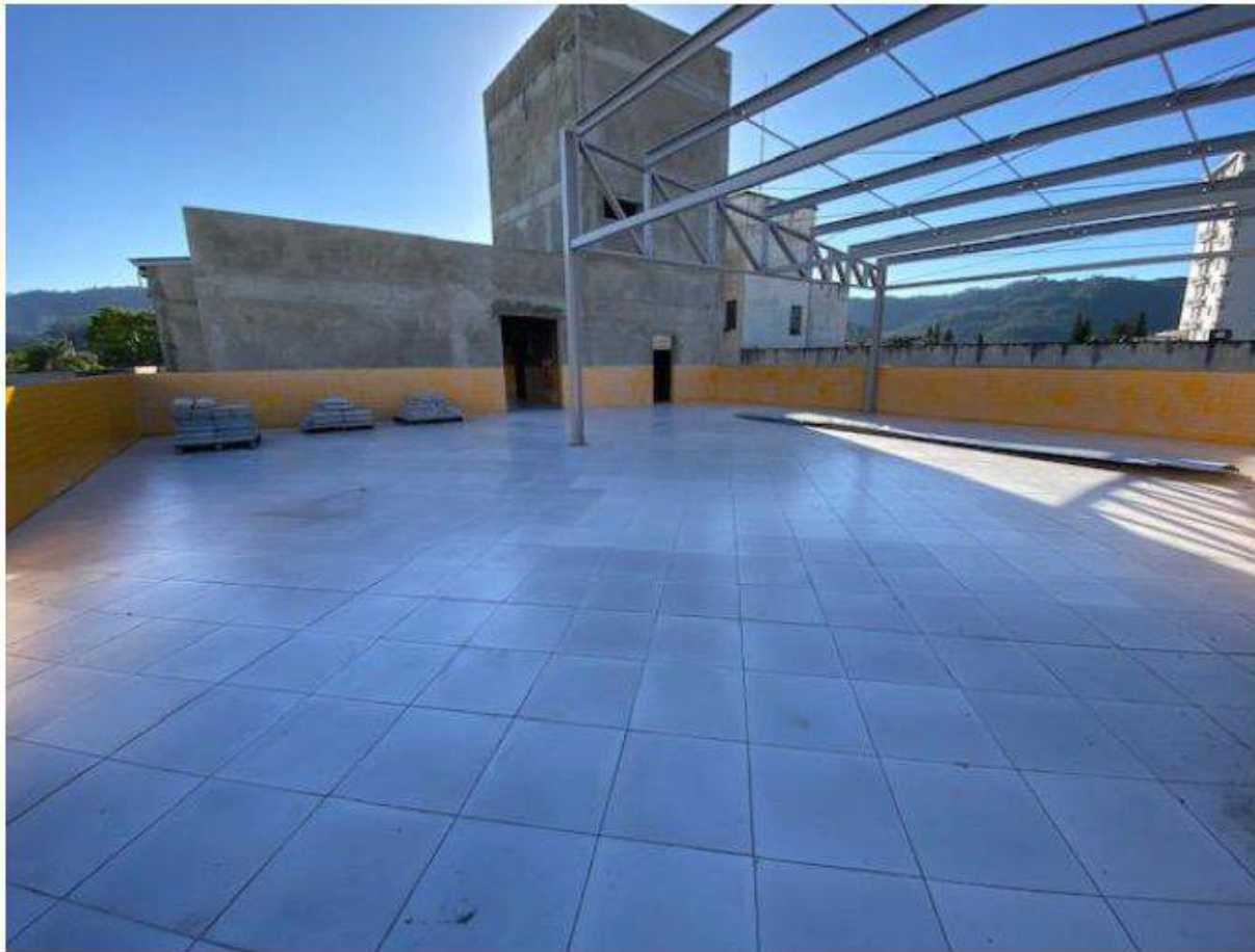
Patio recreação descoberto, alvenaria sem acabamentos superiores e sem instalação placas energia fotovoltaicas
