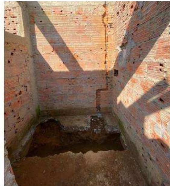
Cortes nas paredes para instalação da infraestrutura hidrossanitária
