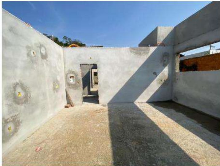
Reboco alvenaria salas de aula
